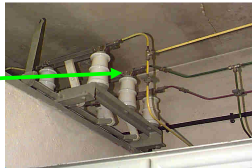
VERBINDUNGSFEHLER IM BEREICH DER MITTLEREN PHASE.
